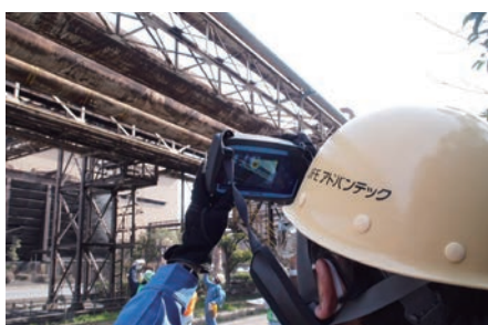
気体漏れ点検作業風景
