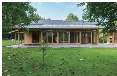
モデルハウスさとのえの南面写真
