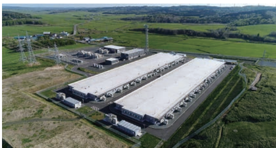
国内最大の蓄電池を併設している当社北豊富変電所の全景
