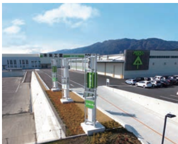
垂井工場全景
