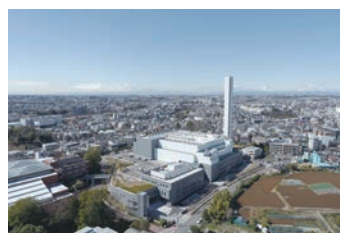
川崎市 橋処理センター
